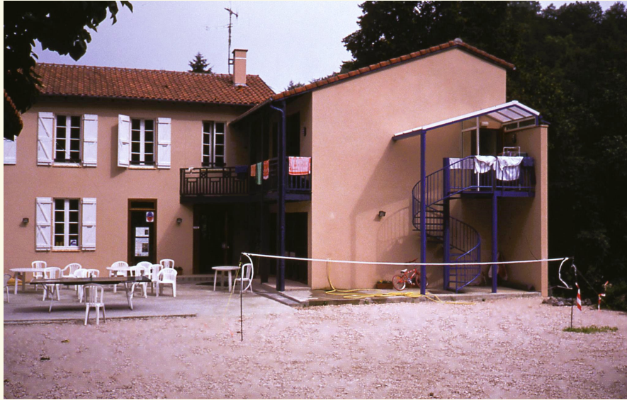
La Maison des Gouffres en 1992, Herran - La Baderque Devenue le Chalet de Paloumère.
